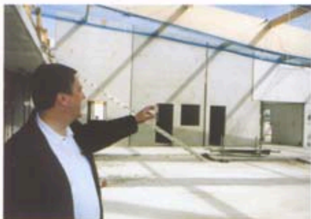
Im August wird die von Dietrich-Fertigbau gebaute neue Produktionshalle in Riesa in Betrieb genommen.
