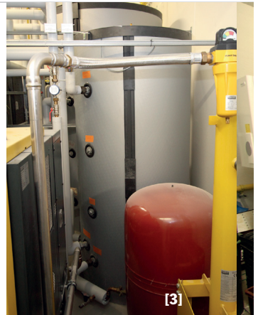
[1]+[2] In einem offenen Anbau ist neben den Abfallbehältern auch die Technik der Solaranlage und der Kühlung untergebracht. [3] Die Wärmerückgewinnung erfolgt über Pufferspeicher mit einem Gesamtvolumen von 4.000 Litern. [4] Jedem Mitarbeiter stehen drei Schränke für seine Miet-Arbeitskleidung zur Verfügung.
