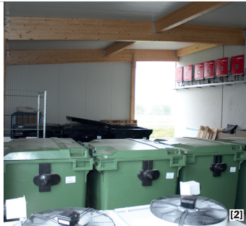
[1]+[2] In einem offenen Anbau ist neben den Abfallbehältern auch die Technik der Solaranlage und der Kühlung untergebracht. [3] Die Wärmerückgewinnung erfolgt über Pufferspeicher mit einem Gesamtvolumen von 4.000 Litern. [4] Jedem Mitarbeiter stehen drei Schränke für seine Miet-Arbeitskleidung zur Verfügung.
