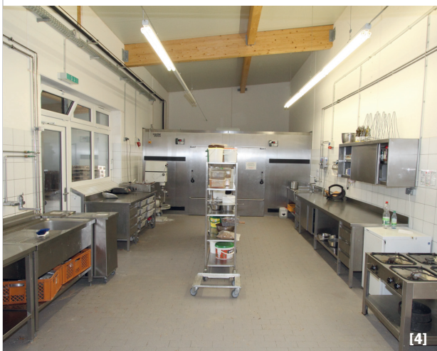
[4] In angemessenem Abstand zur Ofenanlage befindet sich die Konditoreiabteilung. Die ganze Produktion ist übrigens mit splittergeschützten Leuchtstoffröhren-Lichtbändern ausgestattet, die, gesteuert über einen Tageslichtsensor, stets für optimales Licht sorgen. [5] Abgeschrägte, geflieste Fensterbänke verhindern das Abstellen von Gegenständen, die dort nicht hingehören, und vermindern die Ablagerung von Staub. [6] Das neue Rohstofflager ist klar und übersichtlich gegliedert.
