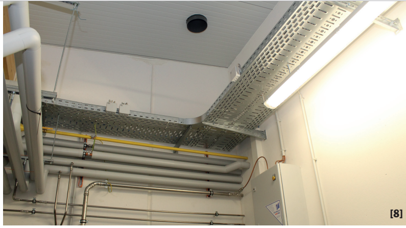
[7] Als überzeugter Bio-Bäcker mahlt beziehungsweise schrotet Roland Postler sein Getreide auf einer Steinmühle, die sich in einem separaten Raum im Lager befindet. [8] Sämtliche Stromleitungen im Produktionsbereich sind in offenen Trassen verlegt. Sie bieten daher Schädlingen keinen Unterschlupf und sind leicht zu reinigen.
