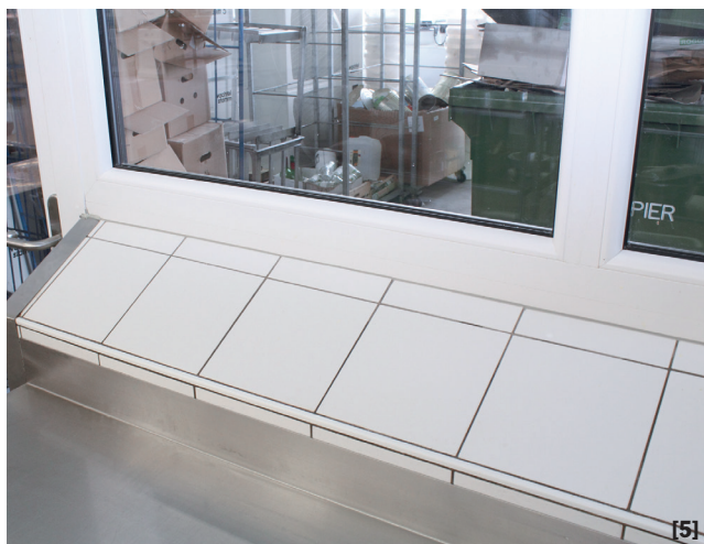
[4] In angemessenem Abstand zur Ofenanlage befindet sich die Konditoreiabteilung. Die ganze Produktion ist übrigens mit splittergeschützten Leuchtstoffröhren-Lichtbändern ausgestattet, die, gesteuert über einen Tageslichtsensor, stets für optimales Licht sorgen. [5] Abgeschrägte, geflieste Fensterbänke verhindern das Abstellen von Gegenständen, die dort nicht hingehören, und vermindern die Ablagerung von Staub. [6] Das neue Rohstofflager ist klar und übersichtlich gegliedert.
