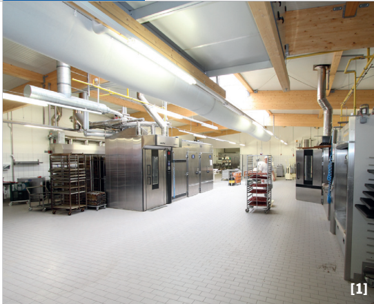
[1] Der Boden der Backstube besteht aus stabilen, rutschfesten Feinsteinzeugfliesen, die mit Rütteltechnik verlegt wurden. Im oberen Bereich des Bildes ist der Textilschlauch der kombinierten Heizungs-, Be- und Entlüftungsanlage zu sehen. Er sorgt für eine ruhige Luftbewegung in der Halle. [2] Das ausreichende Platzangebot vor der Ofen- und Gäranlage ermöglicht eine störungsfreie Ofenarbeit. [3] Auch die Teigmacherei ist übersichtlich und klar gegliedert.
