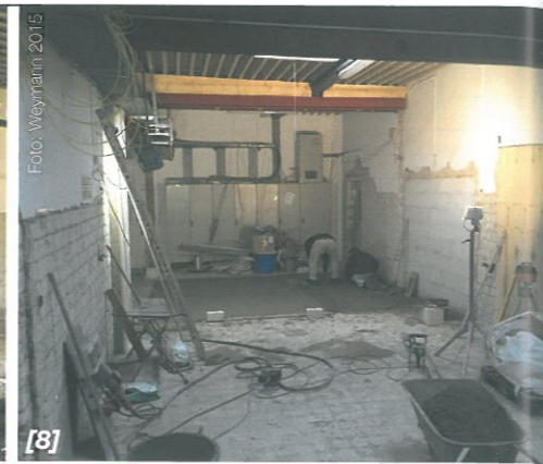
[6] Der Innenbereich der Halle ist offen gestaltet und erlaubt die Planung geradliniger Abläufe. [7] Durch das Öffnen und Schließen von Mauern schafft der Unternehmer neue Wege und Bereiche, die sich vorteilhaft auf den Produktionsablauf auswirken sollen. [8] Im hinteren Bereich wird das Fundament für ein neues Kühlhaus gelegt. Gerade die Größe der Kühlflächen ist in den letzten Jahren stark gestiegen.
